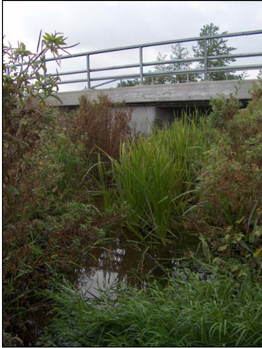
Fig. 3. Växtlighet vid nya landsvägsbron.
